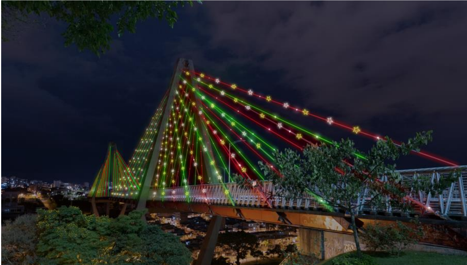
VIADUCTO CESAR GAVIRIA
