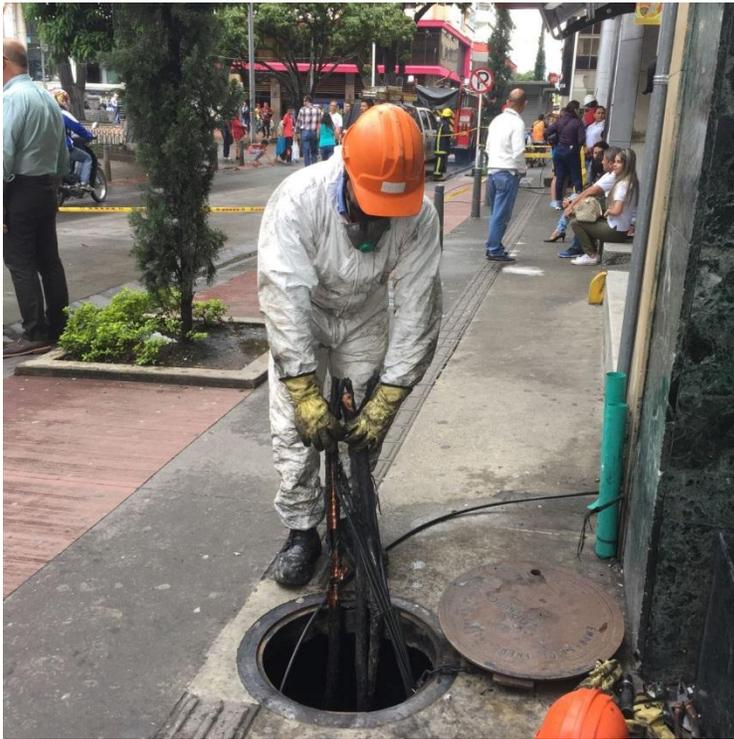
Se confirma que el daño se ubicó en las redes primarias y secundarias subterráneas frente al edificio de la Lotería de Risaralda. Se investiga si la causa del daño fue provocado por un tubo de agua reventado (propiedad de la empresa Aguas y Aguas) que inundó el cárcamo, lo que ocasionó un corto circuito.
