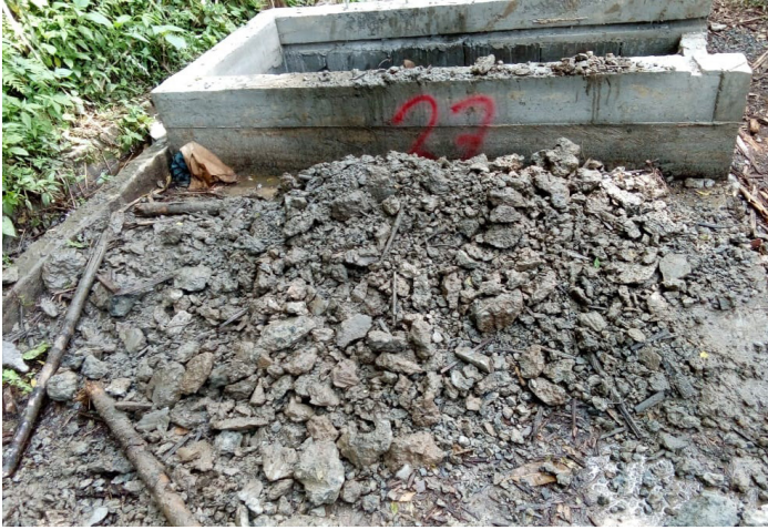
Rehabilitación de chumacera en Generador 1 Planta Belmonte.
