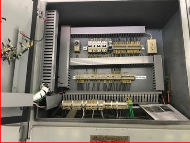
Parte interna del gabinete que aloja relé, borneras y minibreakers.
